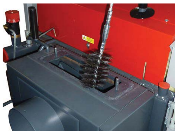
Vorführung der Reinigung des Rauchkanals mit Drahtbürste.
